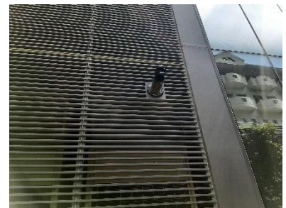
ท่อระบายอากาศเครื่อง Generator
