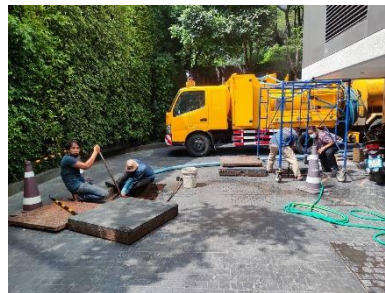
การสูบน้ำออกจากระบบบำบัดน้ำเสีย
